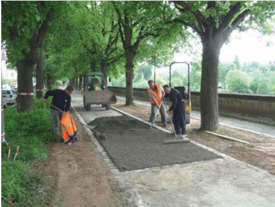
Bild 2: Die Herstellung der Flächenbefestigungen (hier: „Perma-Zyme 11 x“) erfolgte ausschließlich durch die Hersteller oder autorisierte Lizenznehmer.
