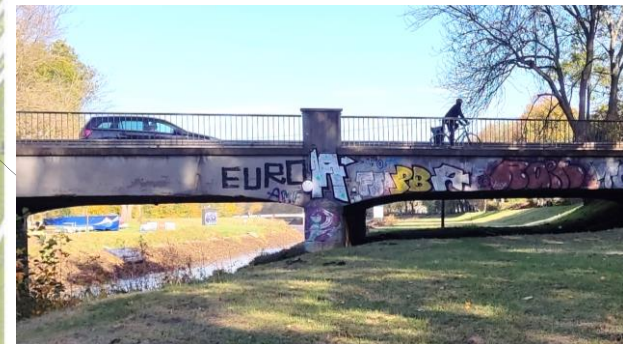
Unterquerung Schleiweg/Beipertbrücke: Gradiente anheben und Vorland absenken
