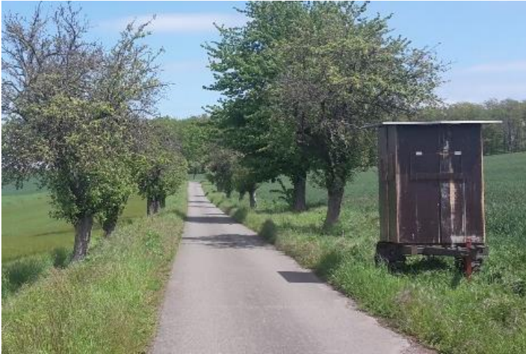
vitaler Seitenbereich: intakte Fahrbahn schützt Seitenbereich vor Befahrung und Verdichtung
