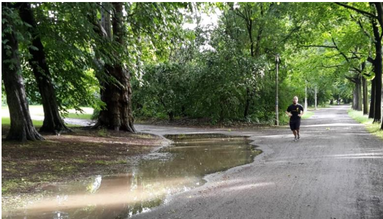
hochverdichteter Wegekörper und Seitenraum: Verschlämmung und ausbleibende Bodenbedeckung infolge fehlender Makroporen und Versickerungsleistung
