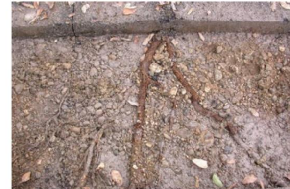
Bild 27: Freilegung (Detailansicht) von Wurzeln unter Dränbelag (Quelle: Heidger)
