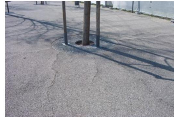
Bild 26: Oberflächenzonalen Wurzelwachstum unter Dränbelag mit Rissbildung (Quelle: Heidger)
