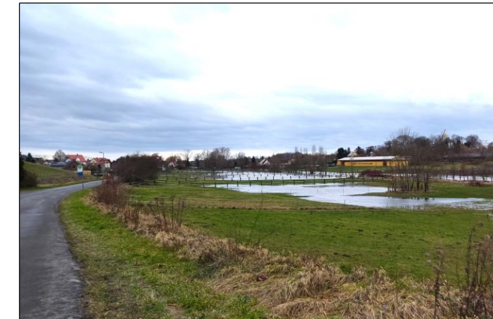
RW48: Panitzsch-Sehls „Neubau straßenbegleit. Radweg“ - geringes Verkehrsaufkommen rechtfertigt keine Neuversiegelung, zumal LSG und randlich FFH - Anordnung T30/50/70 und Markierungen prüfen
