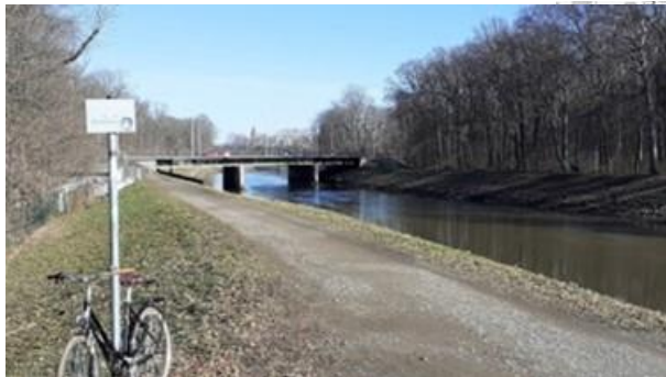
Deich und Blick zum Schleiweg
